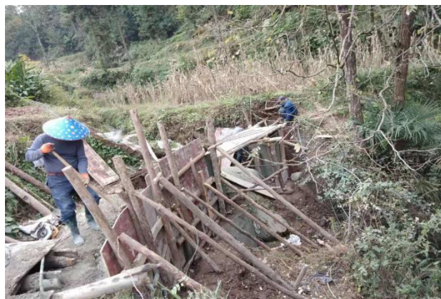
图 1：村民投工投劳修桥中
