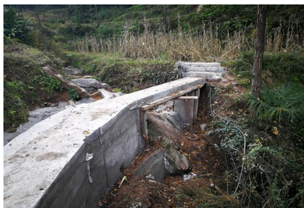
图:2：水泥桥竣工
